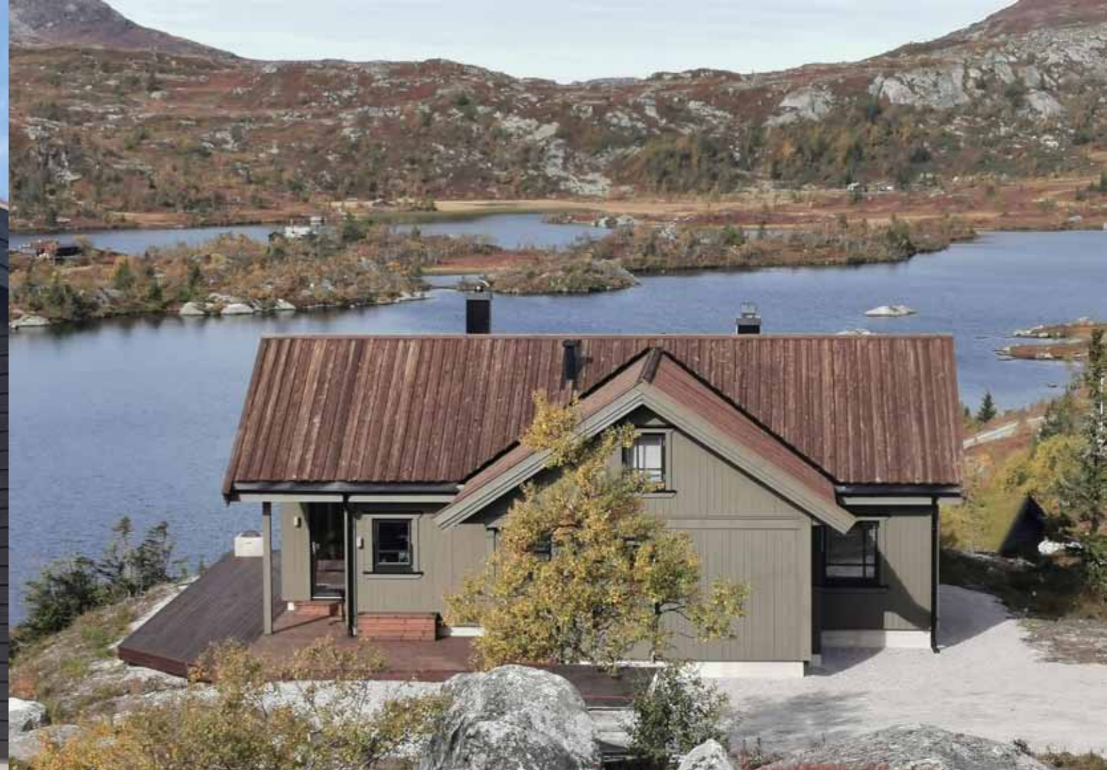
Stående dobbeltfalset rett kledning 19x148 mm.
