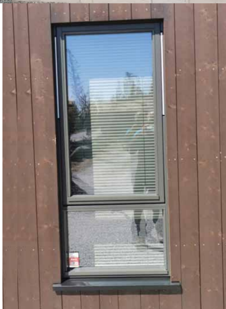
Stående moderne dobbeltfalset tett kledning 19x148 mm.
