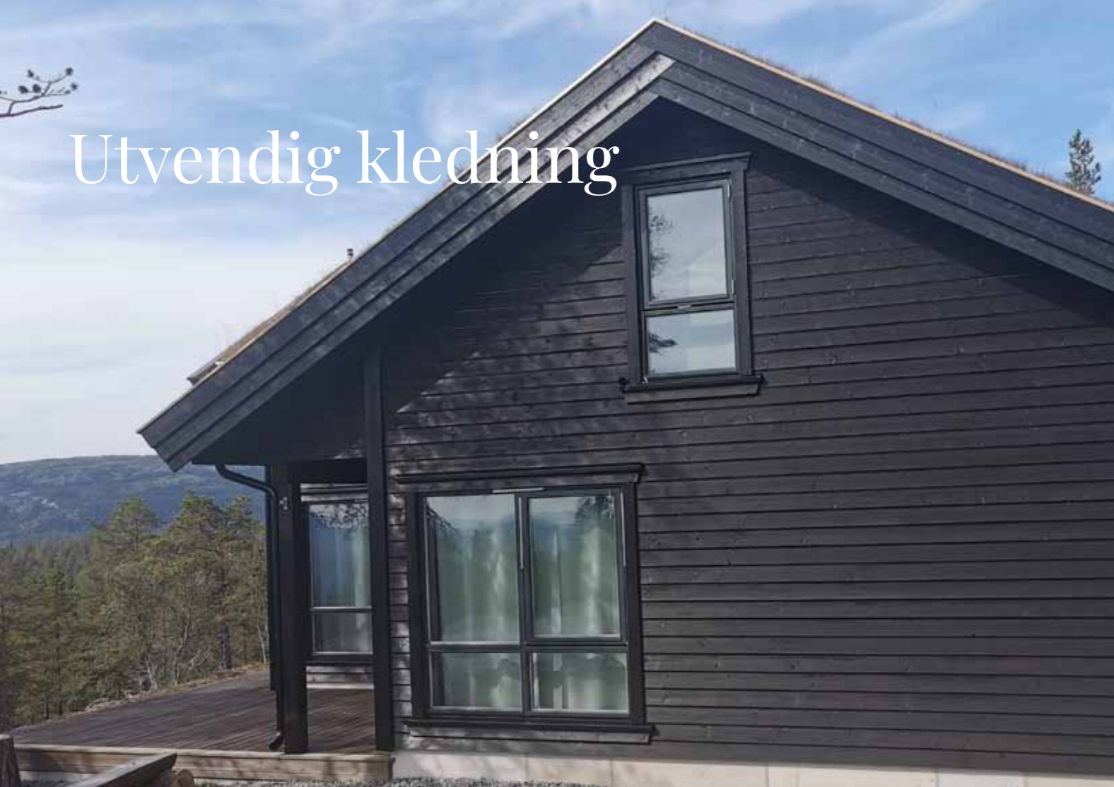
Liggende dobbeltfalset kledning ny profil 19x148 mm.
